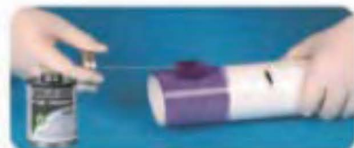
6. Apply the primer to pipe 预粘胶涂抹管道
