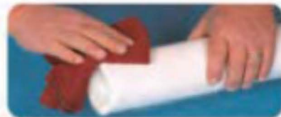
3. Clean the adhesive surface 清洁粘接表面
